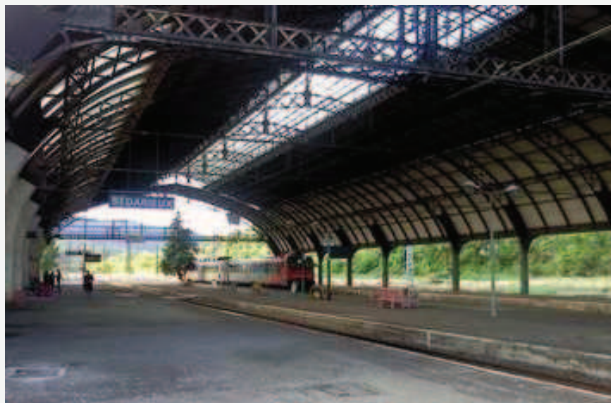
La Marquise de la gare de Bédarieux
