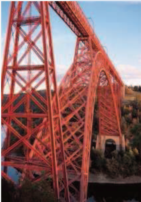
Le viaduc de Garabit
